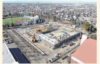
#(仮称)太田市運動公園市民体育館 1月末の様子。手前が正面玄関です
