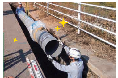
新しい水道管
