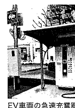
EV車両の急速充電器
