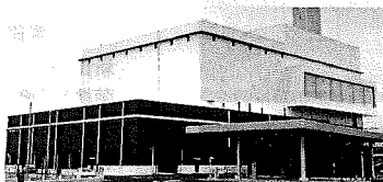
現在、試運転を実施しています 4月から本格稼働する新焼却施設(クリーンプラザ)
