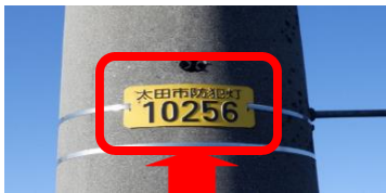
防犯灯管理プレート
