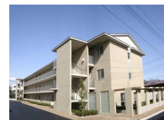
住宅団地（新島市営住宅）
