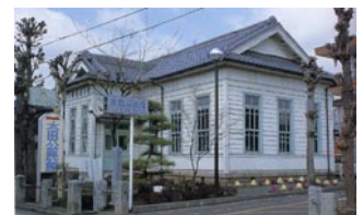
景観重要建造物のイメージ (旧金山図書館)
